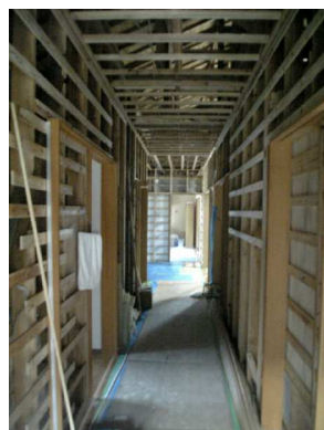
壁・天井内部
